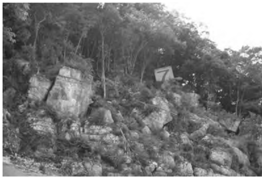
图1 边坡前缘的巨石混合体
