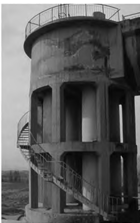
图 1 景电二期总干六泵站某出水塔
