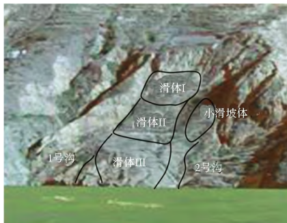
图1 滑坡体原型照片
