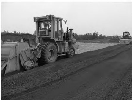
图 2 集中场拌法水泥改性土拌合照片
