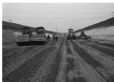
图 3 水泥改性土摊铺碾压照片
