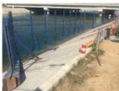
(b) 立柱及支撑结构安装
