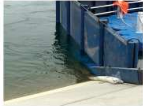
图 18 底座外围阻水沙管
