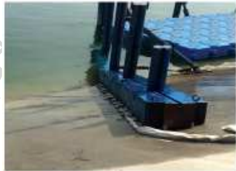
图 19 底座外围阻水棉花管
