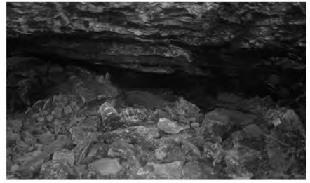
图6 隧底溶洞开挖
