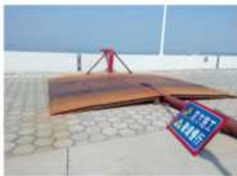
图 4 坝上管道铺设
