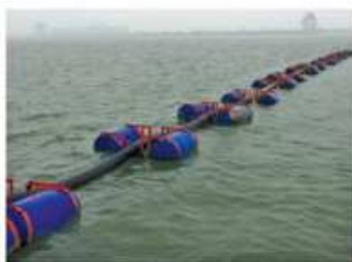
图 3 水上浮筒与管道
