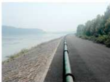
图 5 坝下管道铺设
