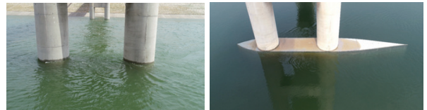
(a) 导流罩安装前流态 (b) 导流罩安装后流态
