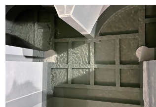
图 6 闸室水流流态
