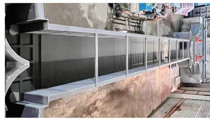
(c) 船闸整体
