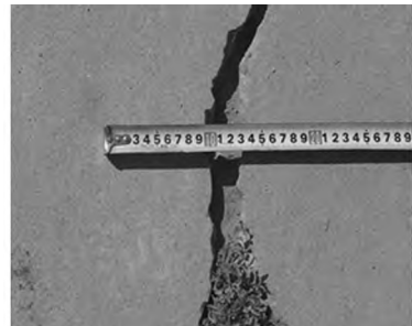
图 5 坝顶混凝土路面现状
