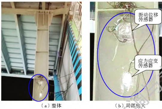
图 4 传感器现场安装照片(上支臂)
