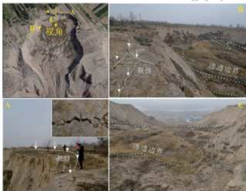
图 3 黑台泥流型滑坡现场
